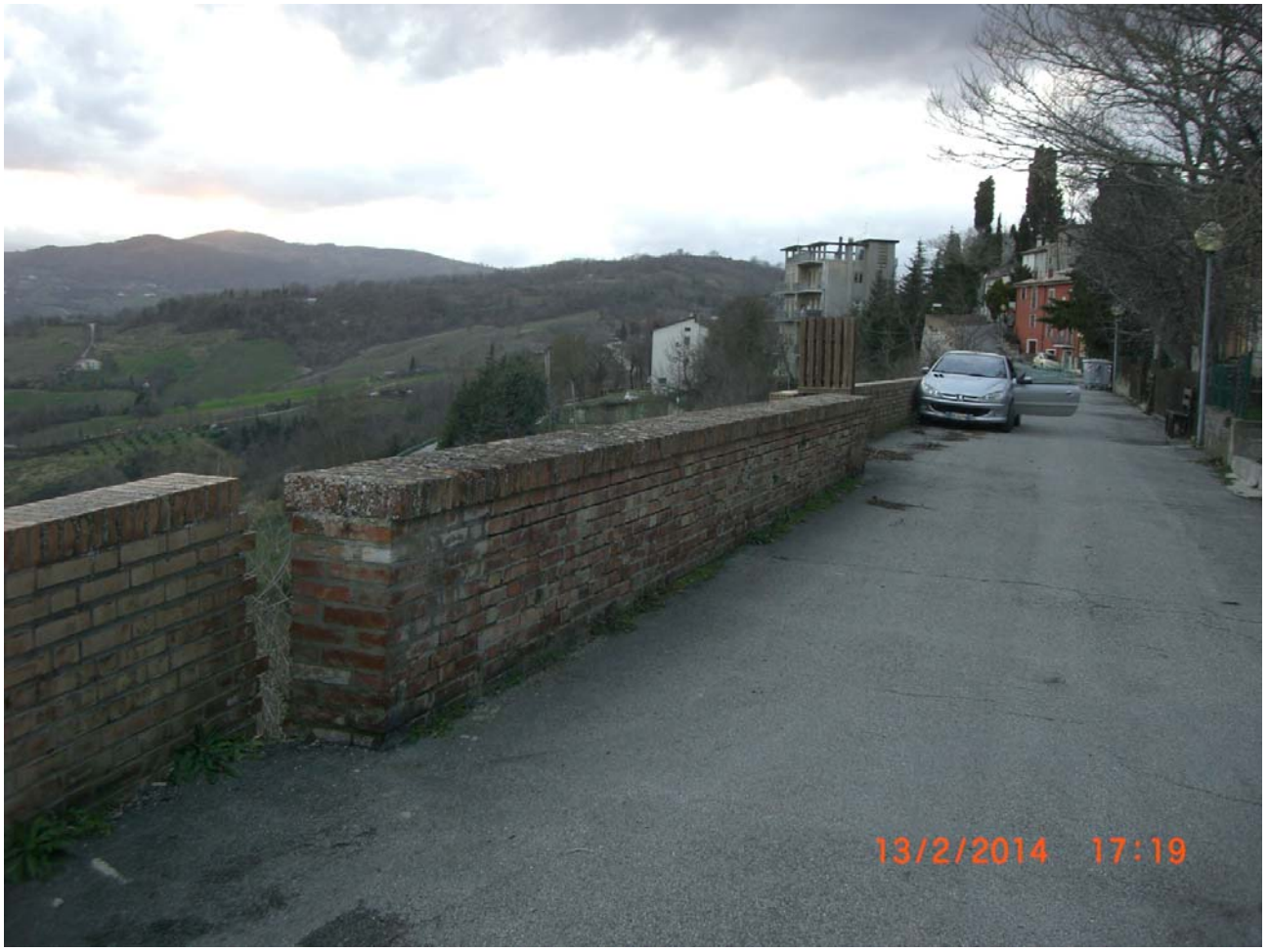
Zona di intervento B2: tratto del muro di cinta su via circonvallazione da demolire e ricostruire in linea con la restante mura di cinta.
